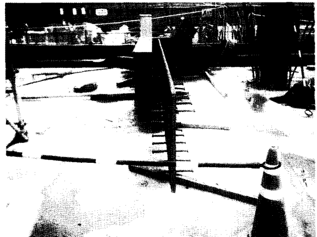
[사진 1] 철골트러스에 설치된 스태드 볼트
