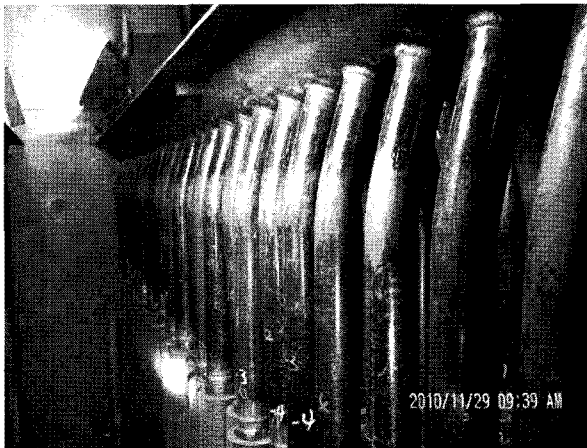
[그림 11] LP Eva. 상부 Header Stub 교체상태
