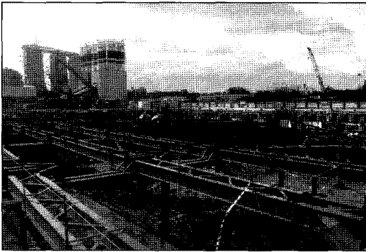
그림 6. 흙막이 가시설 굴착 전경
