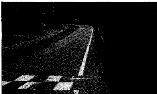
시공전 (보행자도로 없음)
