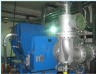
기기 명 : 증기터빈 발전기 입구압력: 10kg/cm 2 입구온도: 183.2°C 용 량: 250kW
