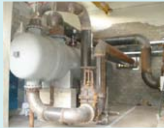
기기 명 : 터빈 열교환기 형 식 : Shell & Tube 용 량 : 4.6ton/hr
