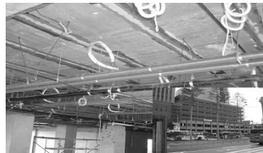
남대문경찰서 리모델링 중 구조보강공사
