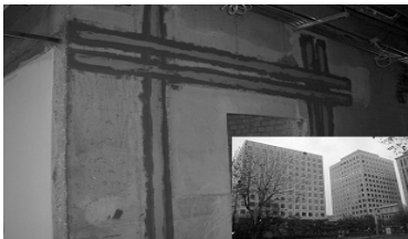
현대아산 사옥 리모델링 중 구조보강공사
