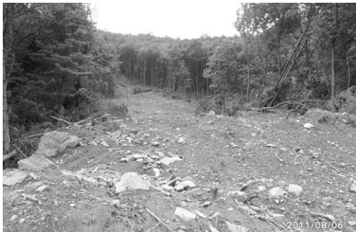
〈도솔암 배후 상부 비탈면 붕괴 전경〉
