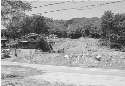
그림 12. 강원도 춘천시 펜션 배후사면 피해지역 전경(윤찬영와 서흥석, 2011)
