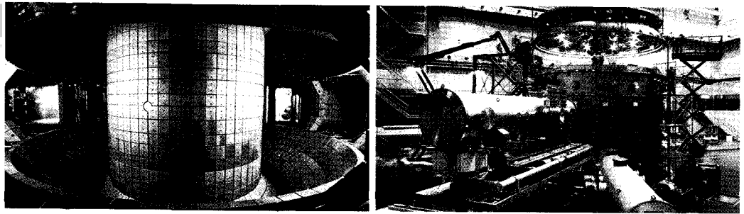
▶▶ 진공용기 내부(플라즈마 대향장치 및 디버터) 모습과 진공용기 조립
