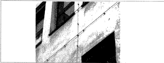
【그림 18】 일반건물의 외벽에 설치한 메시 도체[20]
