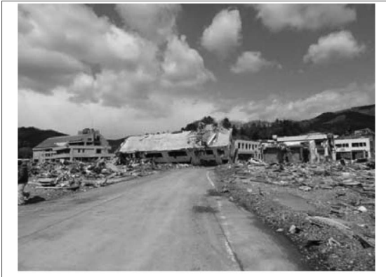
〈사진 8〉 2층 및 3층 철근콘크리트 건물의 피해 (2011년 3월27일 촬영)
