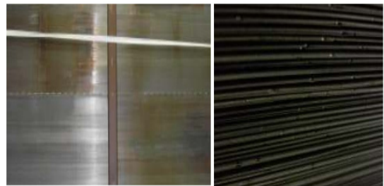
그림 13 철심면 과열 및 아크손상 Fig. 13 Heating and arcing damage of Core
