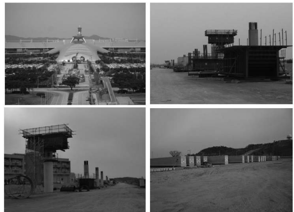
그림 16. 인천국제공항 시범노선 공사 현장
