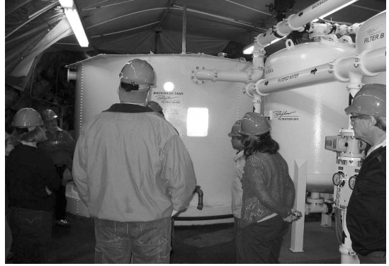
그림 8. Wasatch 배수터널내 정수시설
