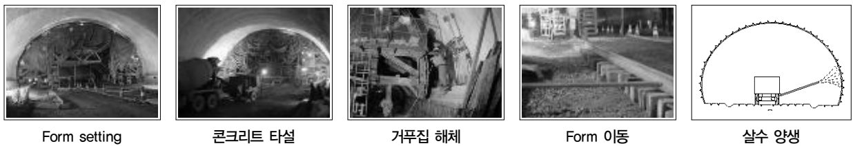
그림 3. 기존의 라이닝콘크리트 타설 Cycle
