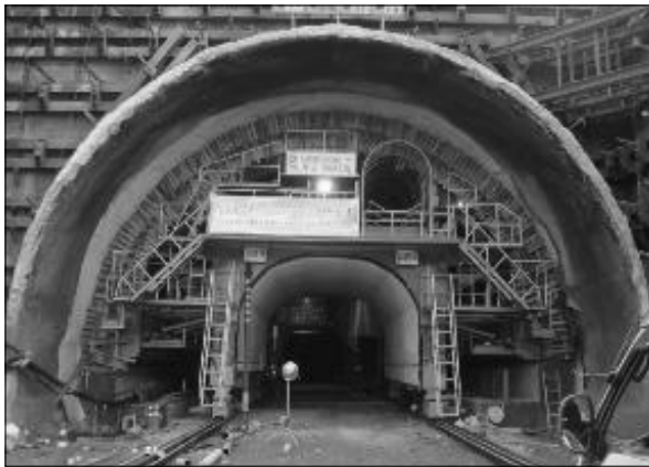
그림 2. Sliding Form(왼쪽)과 양생대차(오른쪽)
