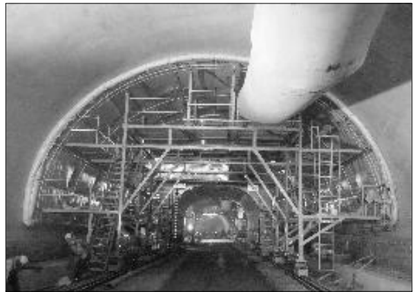
그림 2. Sliding Form(왼쪽)과 양생대차(오른쪽)
