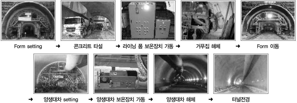
그림 4. 개선된 라이닝콘크리트 타설 Cycle
