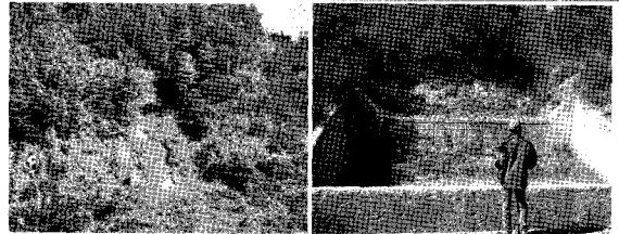
〈그림 8〉 계곡부에 설치된 콘크리트 사방댐
