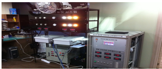
그림 7 태양광발전설비와 연계한 경관조명 전력제어시스템 실험장치 Fig. 7 The experiment device of landscape lighting power control system with solar sell generator equipment
