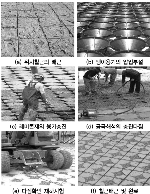
그림 4. 현장타설형 팽이말뚝 기초의 시공방법
