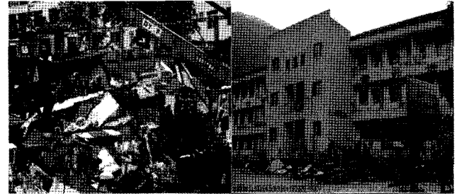
(b) 기존교사동 완전붕괴 (c) 신축교사동 하부 2개층 붕괴
