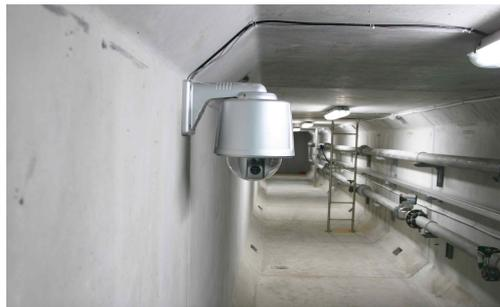
FIGURE 12. TestLab 공동구 내부의 CCTV
