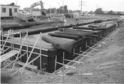
사진 3. 수직벽을 위한 지오그리드와 매트릭스 탱크 모듈 설치
