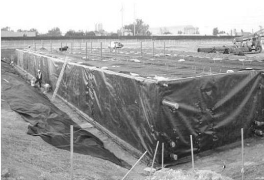
사진 4. 지오멤브레인 (차수막) 설치
