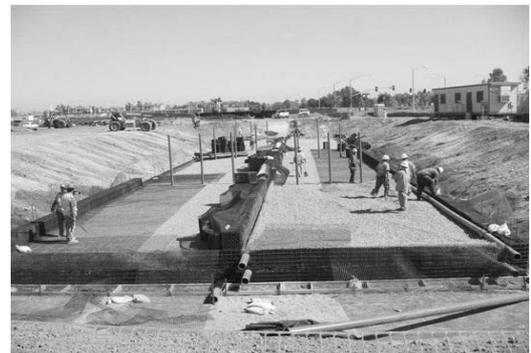
사진 2. 표면이 거칠고 둥근 형태의 자갈을 바이오 필터셀에 투입후 다짐(Compaction)
