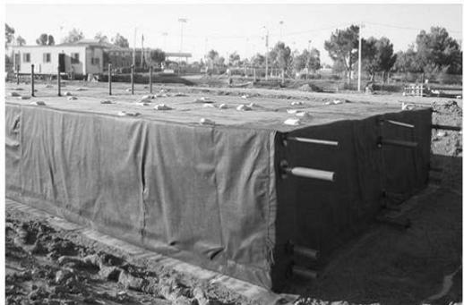
사진 5. 외부환경으로부터 지오멤브레인을 보호하기 위한 지오텍스타일 설치
