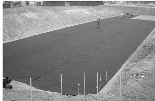
사진 1. 지오멤브레인 라이너 설치
