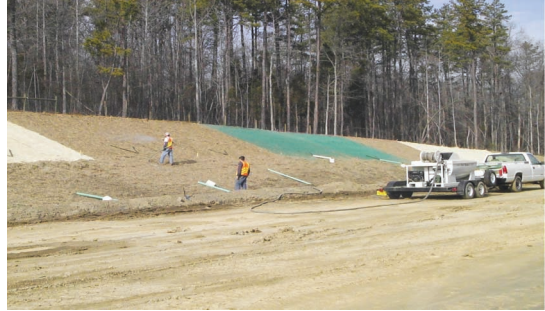
그림 2. 하이드로시더를 이용한 절토면 안정화 작업
