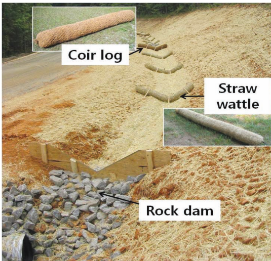
그림 4. 도로 공사 측면 배수로에 설치된 부땀들
