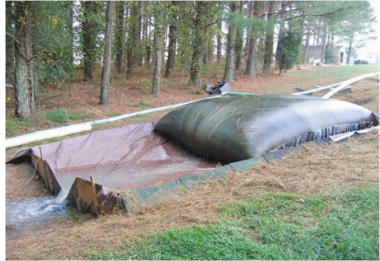
그림 8. 토사 탈수백 (Sediment dewatering bag)을 이용한 탁수 처리
