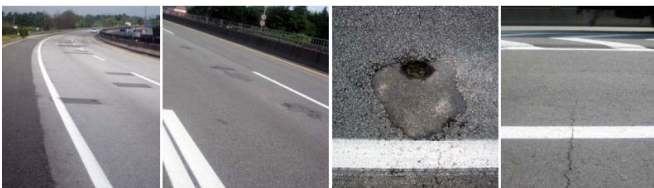
그림 1. 중부 및 호남 고속도로에 아스팔트 덧씌우기 공법이 적용된 구간의 파손(김형배 외, 2008)
