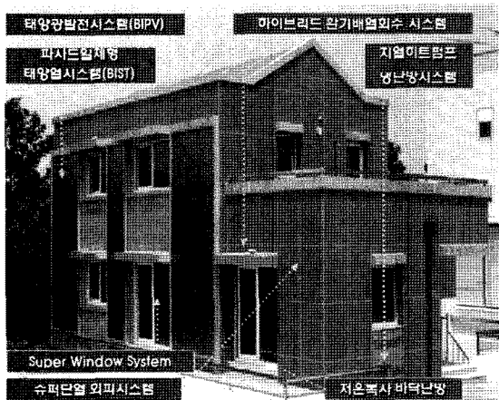
[그림 2] ZeSH-II 전경 및 주요 적용기술
