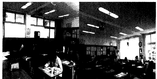
그림 2. 교실에 설치된 LED 조명 환경
