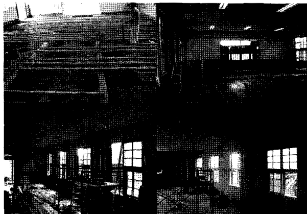
그림 10. 시공사진(바닥철거 및 벽체공사)
