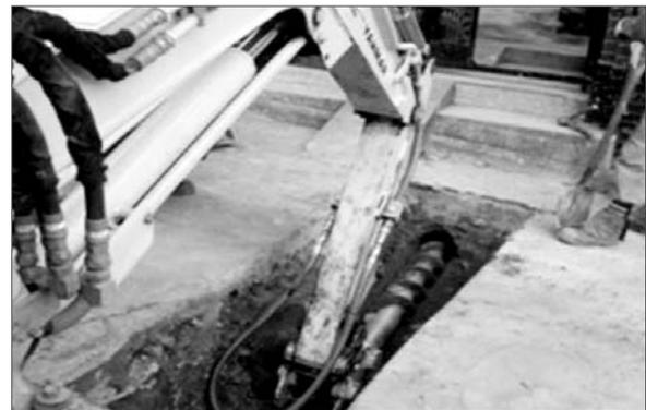
Fig. 3 천공장치를 이용한 배수설비 연결관 공사 개요도 및 시공사진
