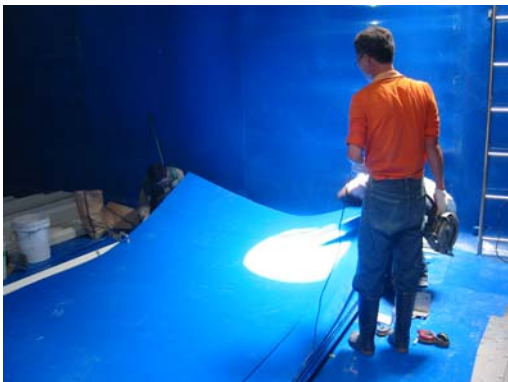
Fig. 2 염소 접촉조 라이닝 현장(측벽 및 바닥면까지 PE로 라이닝)
