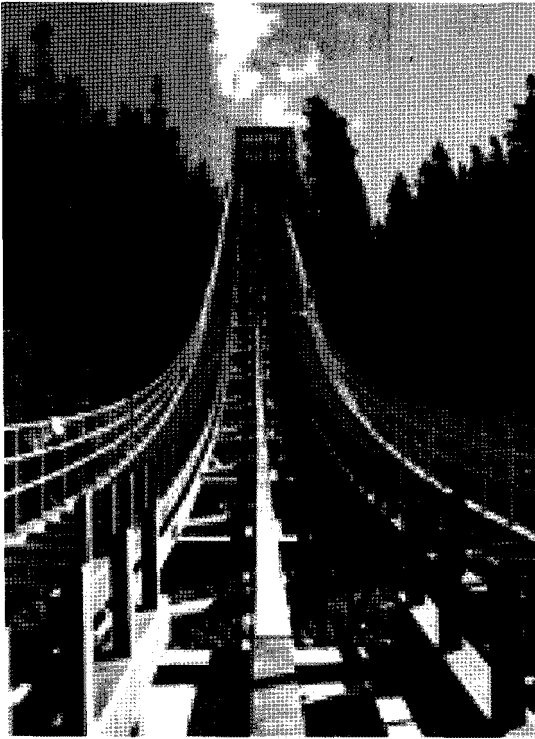
그림 7. 동계 올림픽을 위한 95~125 미터의 크고 무거운 트러스 구조물인 스키 점프대는 산중턱에 조립되기 전에 폭이 넓은 배와 특별하게 만들어진 운송 수단으로 수송된다.
