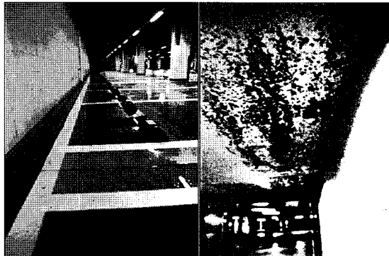
[그림 1] 지하주차장 엘리베이터 전실 및 계단실에서의 결로발생 사례
