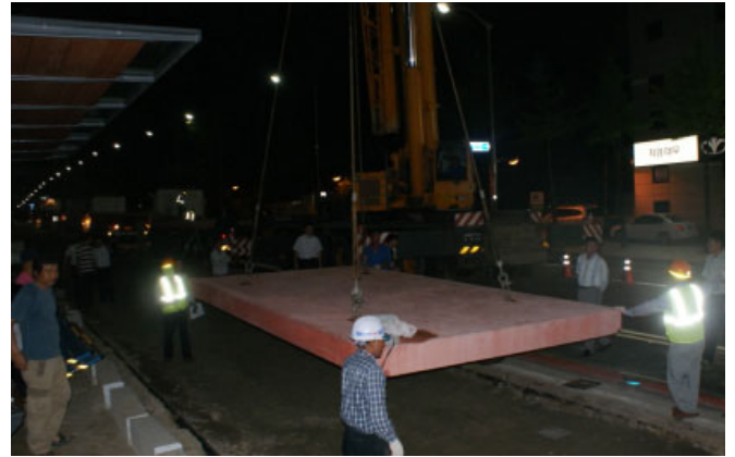
그림 6. 프리캐스트 슬래브 안착 작업
