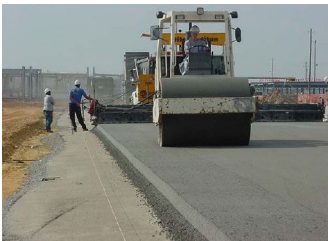
그림 2. 롤러 전압 콘크리트 포장 시공 전경
