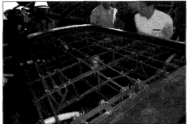
그림 10. 세그먼트 Steel Cage 검수
