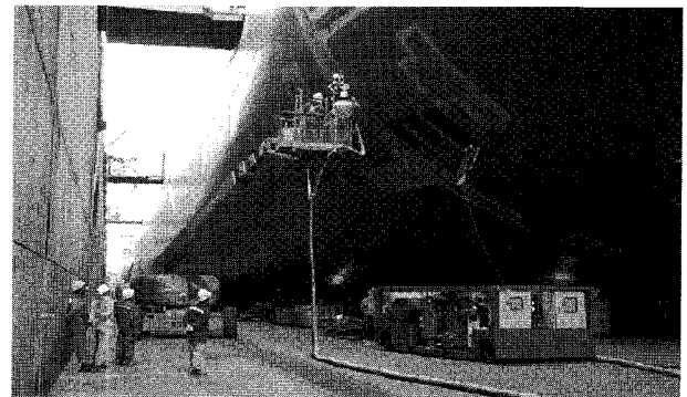
그림 5 조선소내 선체 블라스팅 로봇 작업 사진
