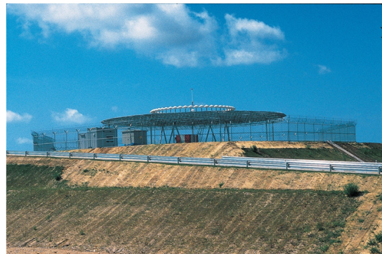
그림 1. DVOR 설치 예 Fig 1. example of DVOR installation
