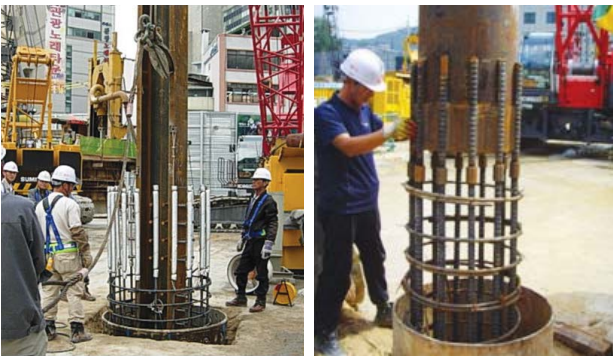
(a) 거치식 연결을 이용한 기존 H형강 선기초기둥 (b) 커플러를 적용한 원형 CFT 선기초기둥
