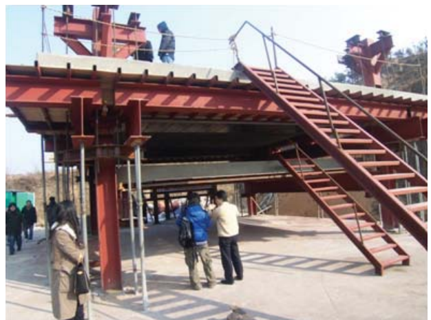
그림 3. 무지주 거푸집 Mock-up Test
