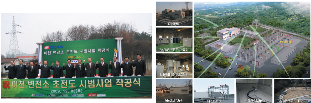
그림 1 22.9kV 초전도 전력기기 실계통 시범사업(GENI Project)
