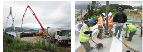
사진 3. 발라스트 콘크리트 타설 전경
