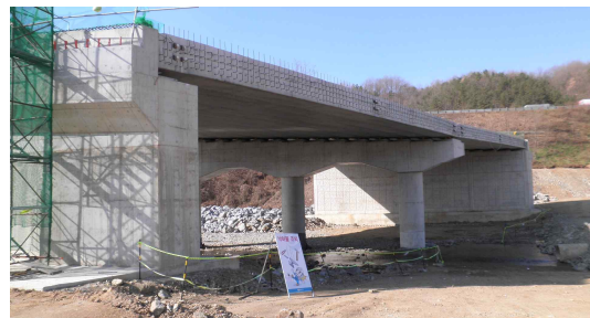
사진 3. 백운교 거더 가설 후 전경
