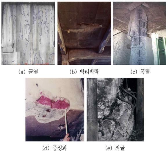
사진 3. 화재피해를 입은 콘크리트 구조물의 피해형태<sup>1, 2)</sup>
