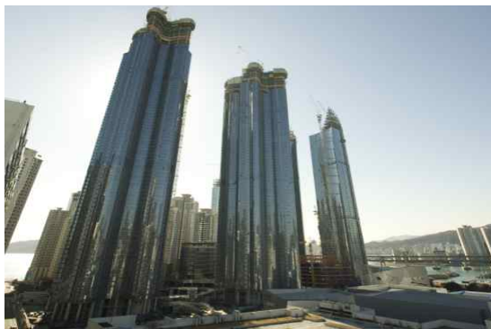
사진 6. 현재 공사현장 전경(2010.12)
