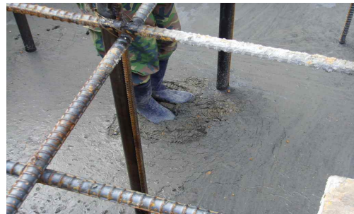
사진 2. 초지연 콘크리트 응결상태 확인
