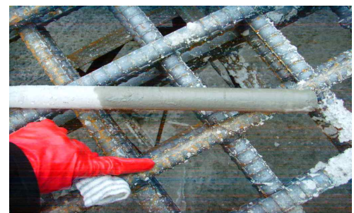
사진 3. 타설 익일 콘크리트 응결상태
