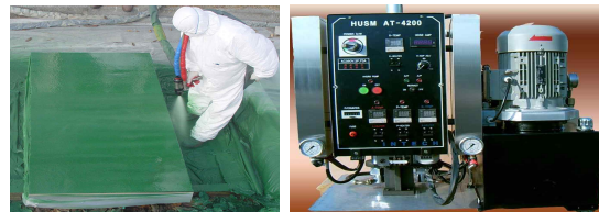
그림 6. 폴리우레아 시공 장면과 시공 장비
