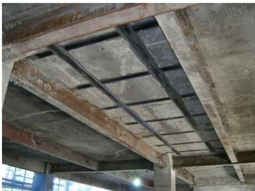
사진 1. 탄소판을 이용한 슬래브 힘보강(대우건설, 2008)
