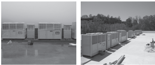
[그림 4] 열펌프 냉동유닛 설치
