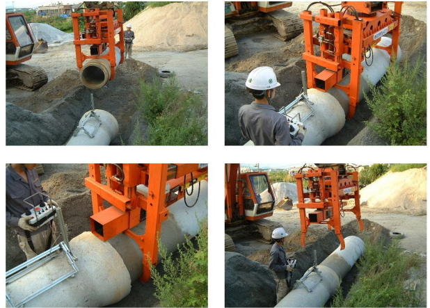
그림 5 하수도관 매설공사시 도관 정렬 자동화를 위한 센서 [삼서공업, KITECH, 한국] 10)
