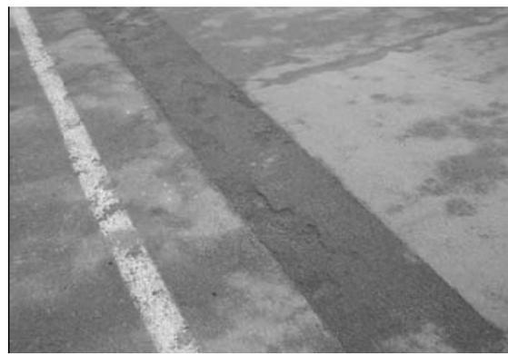
그림 6. FRP 연결부의 Crack
