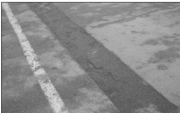
그림 11. 적절치 못한 시공으로 인해 발생하는 포장면의 파괴
