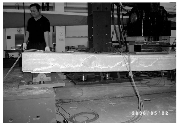
(a) 하이브리드 GFRP-강재 바닥판의 측면에서의 파괴모습
