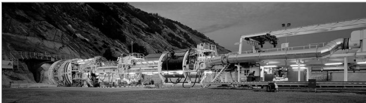
그림 4. 터널 갱구부 TBM 발진(Launching) 전경
