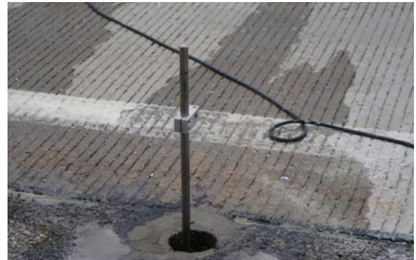
(a) 거치대 설치
