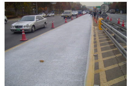
(f) 2차 시공 완료 후 전경
