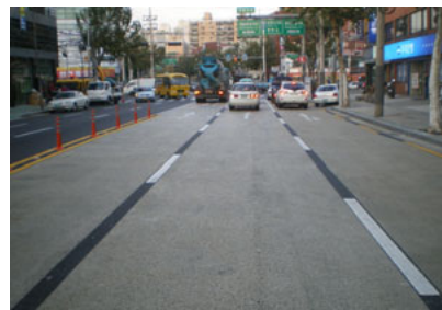
(e) 1차 시공 완료 후 전경
