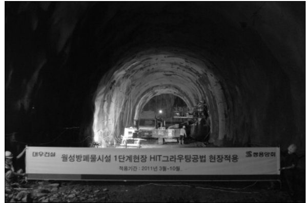
그림 9. HIT 그라우팅 공법의 현장적용
