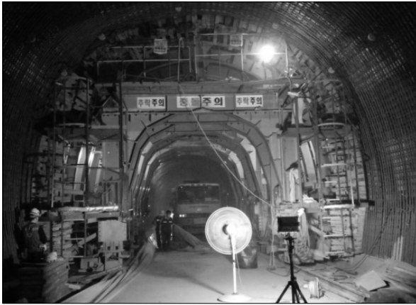
그림 13. 건설동굴 라이닝콘크리트 타설 전경
